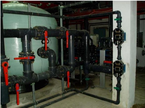
Четыре установки NEC-4001.8, бассейн объемом 3000м<sup>3</sup>, расход энергии на оборудование водоподготовки - 600 ватт/час.
